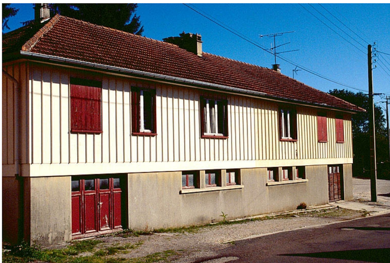
Logement double à étage (maison Fillod).
