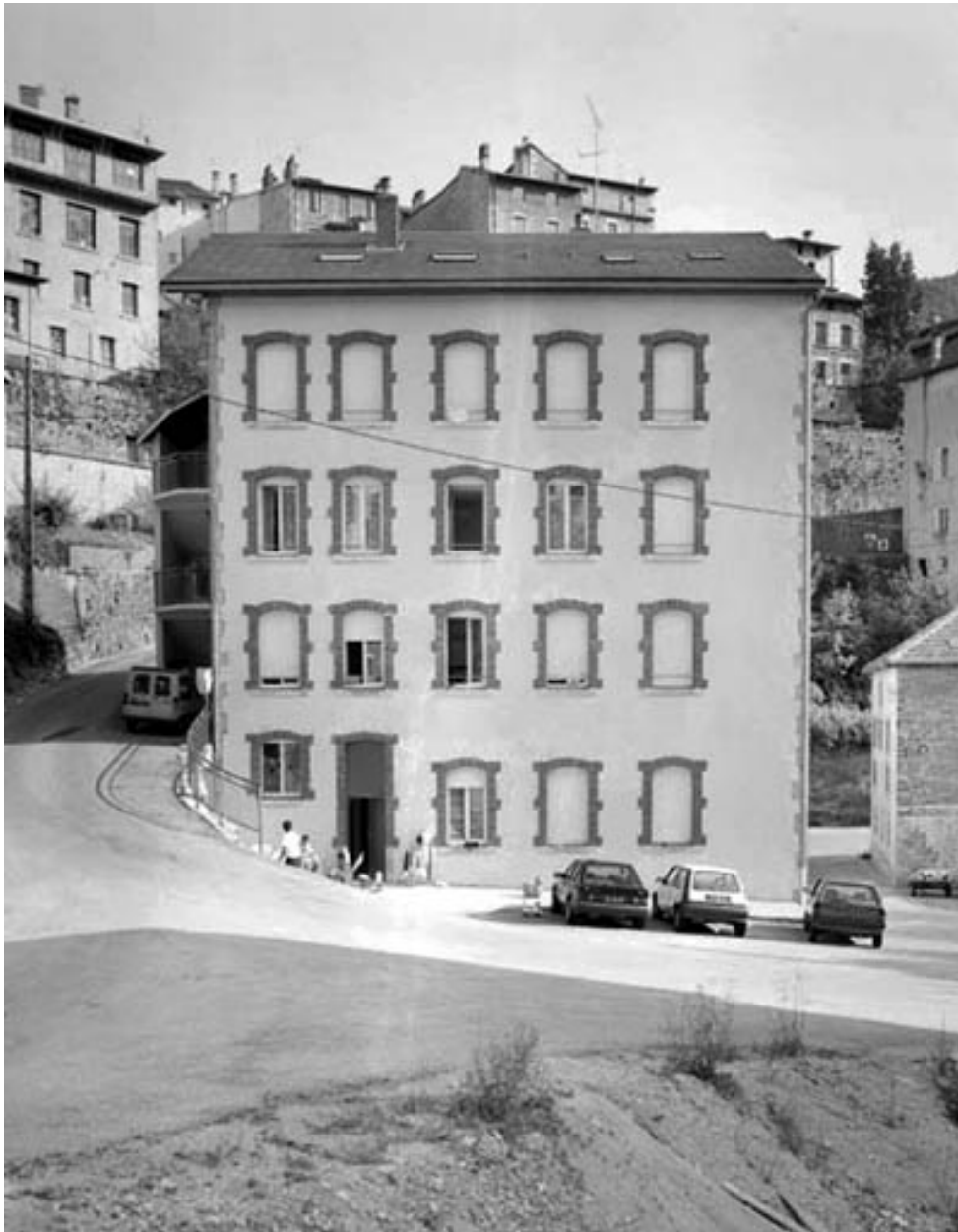
Immeuble (ancienne maison Vuillard) : façade antérieure.
