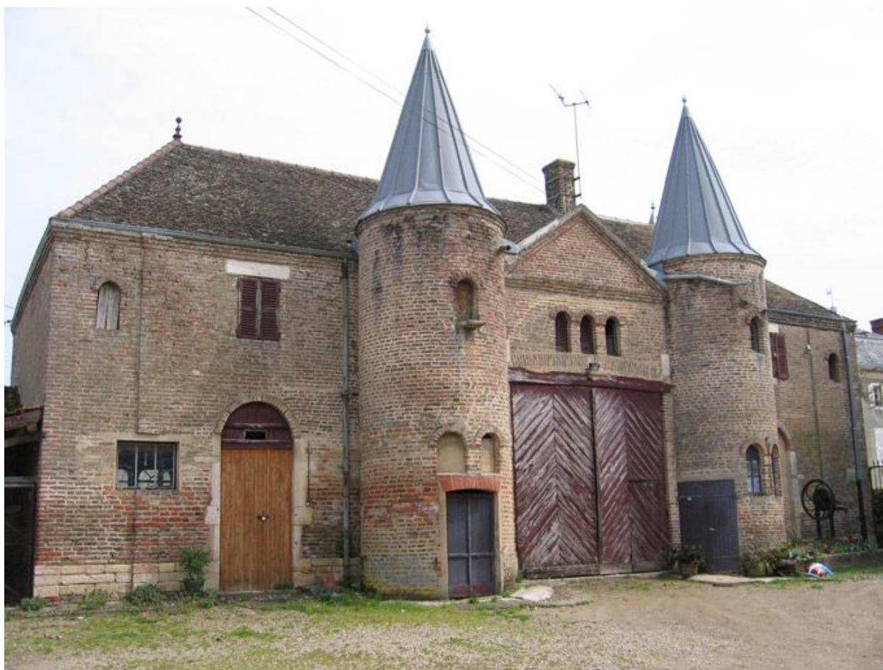
Vue d'ensemble de la façade.
