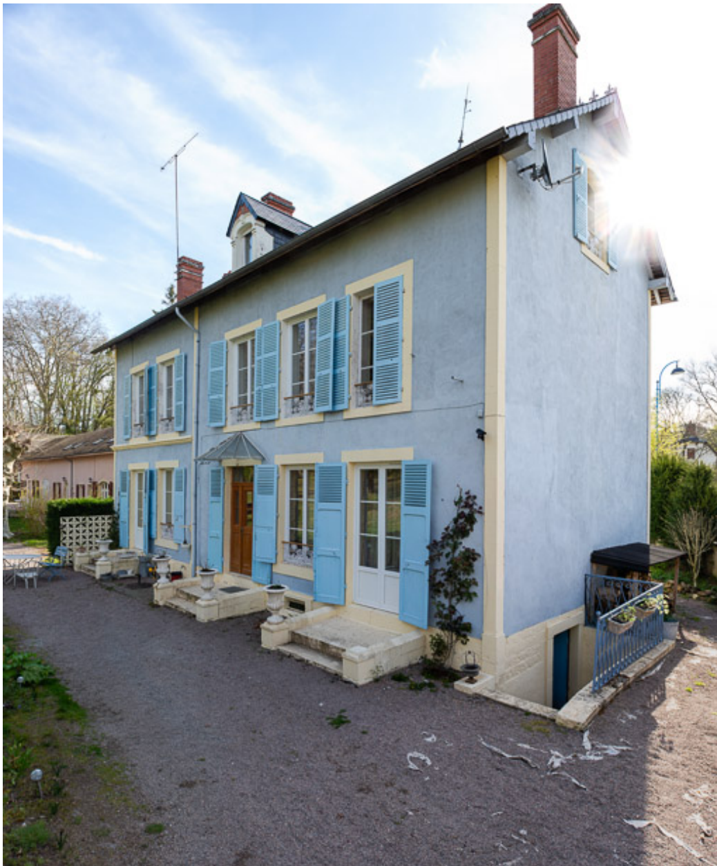
Façade nord-ouest et pignon sud-ouest.
