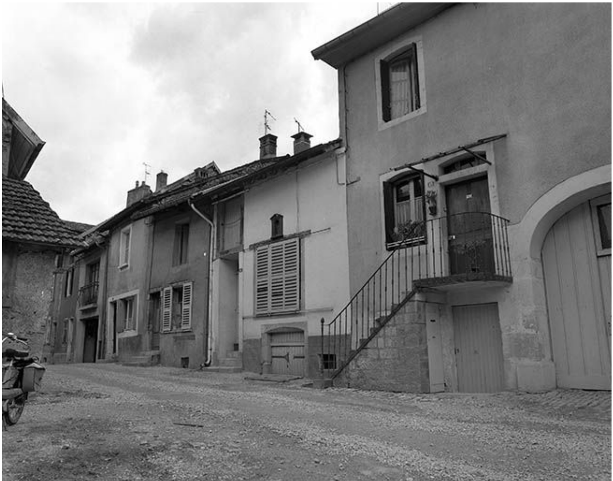
Maisons 11 à 13 rue des Martinets : vue générale.
