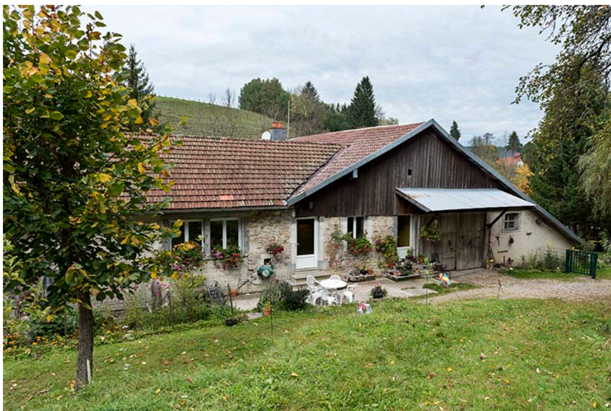
Moulin et logement : façade est.
