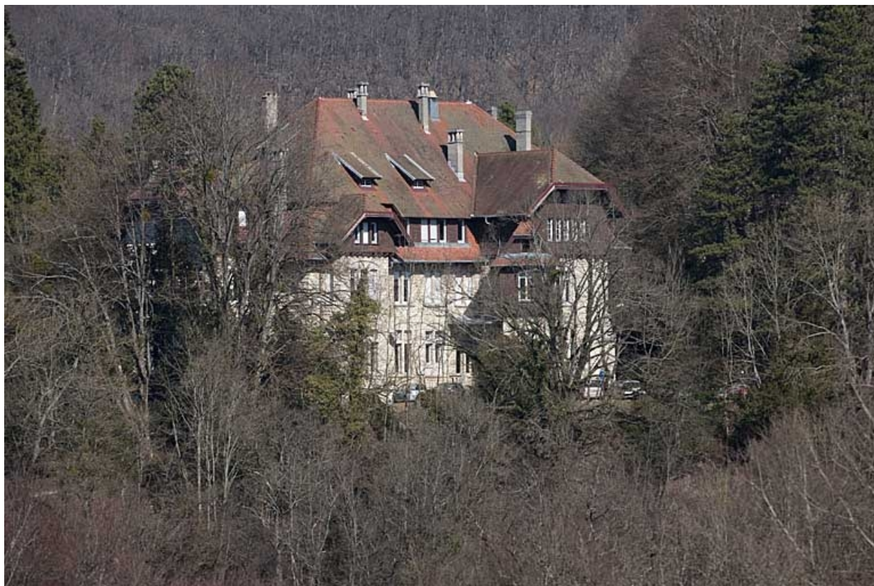
Vue éloignée depuis le sud-ouest.
