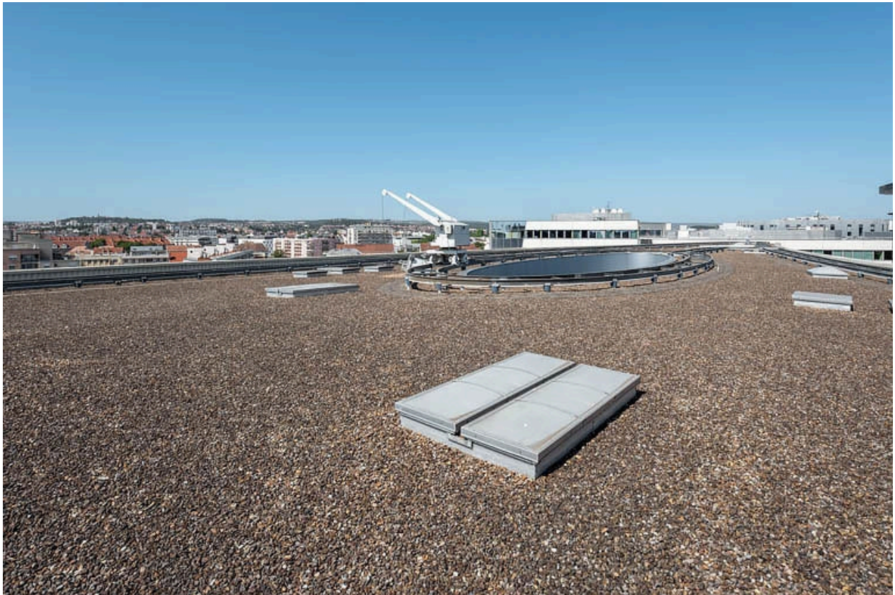
Toit terrasse au-dessus de la salle.
