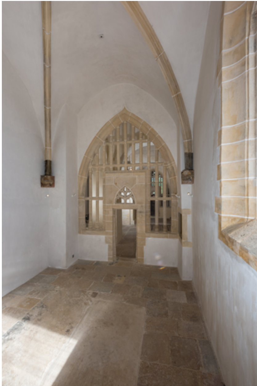
Vue intérieure de chapelle vers le nord.
