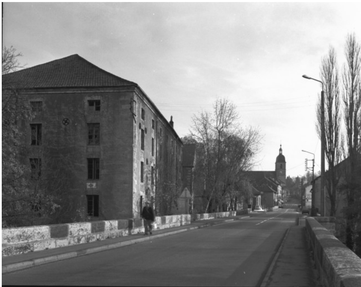
Vue générale de trois quarts gauche en 1989.
