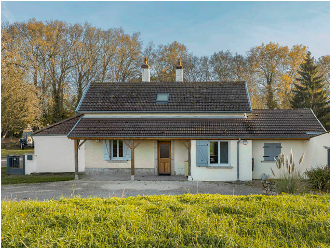
Vue de face de la maison.
