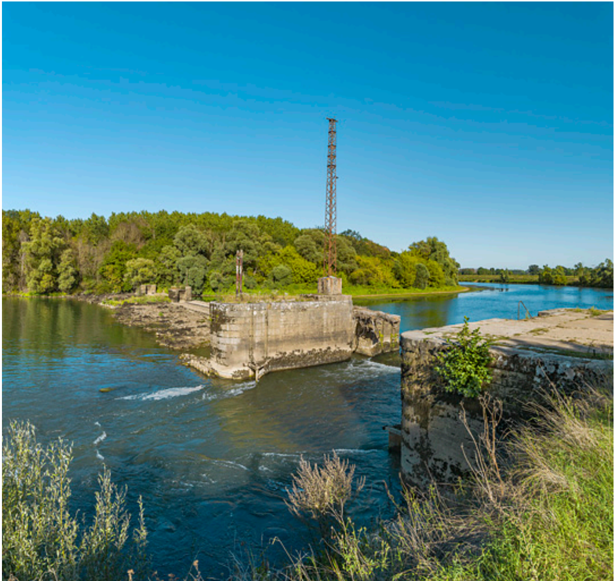
Vue d'ensemble du barrage en 2019 : au premier plan, l'ancien pertuis.
