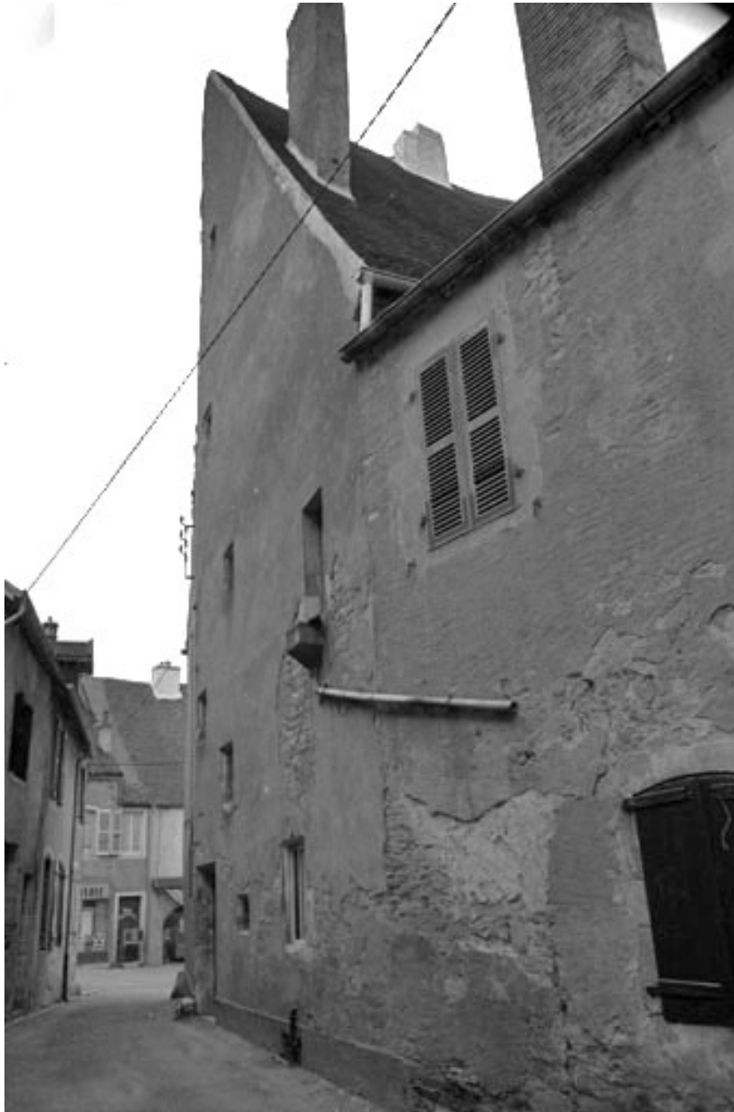
Maison située 33 Grande Rue avec escalier en vis intégré dans le volume de l'édifice.
