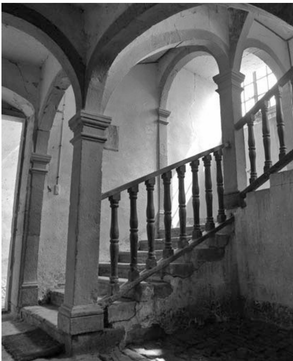
Escalier intérieur : première volée.
