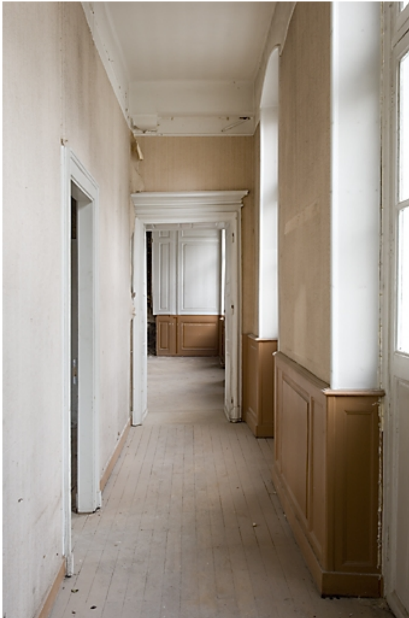
Vue d'ensemble du couloir au premier étage.
