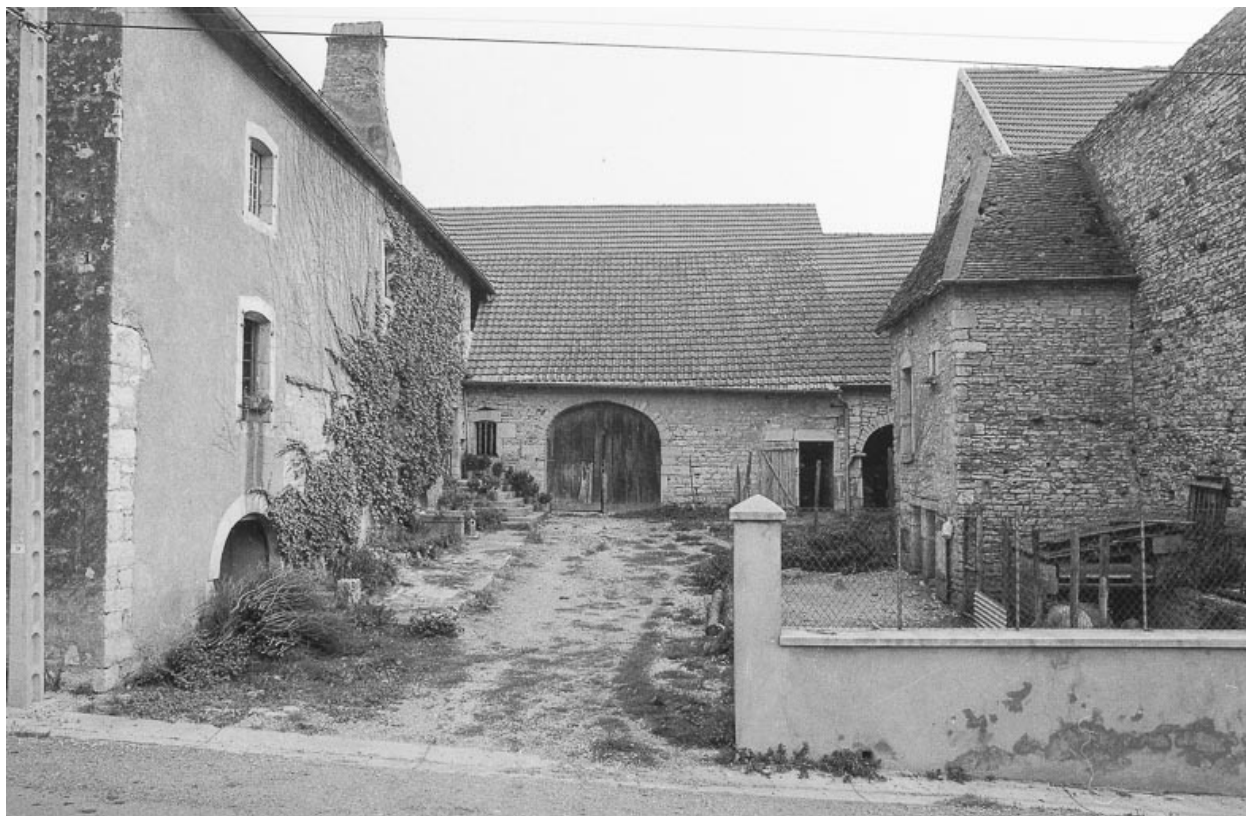
Façades sur cour.
