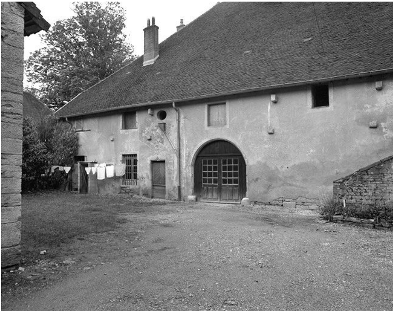
Façade antérieure, partie gauche.
