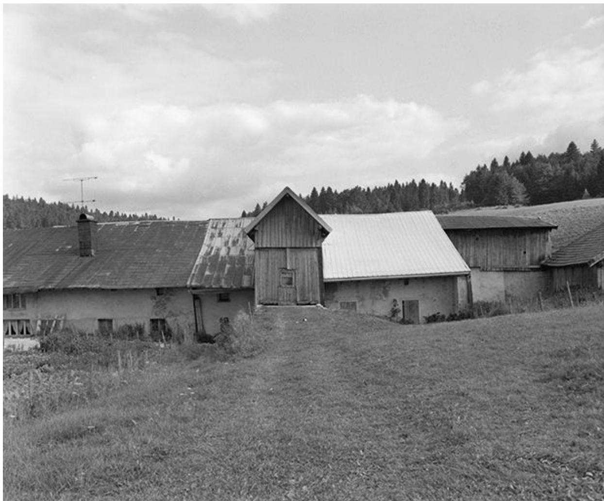
Façade postérieure avec pont de grange.
