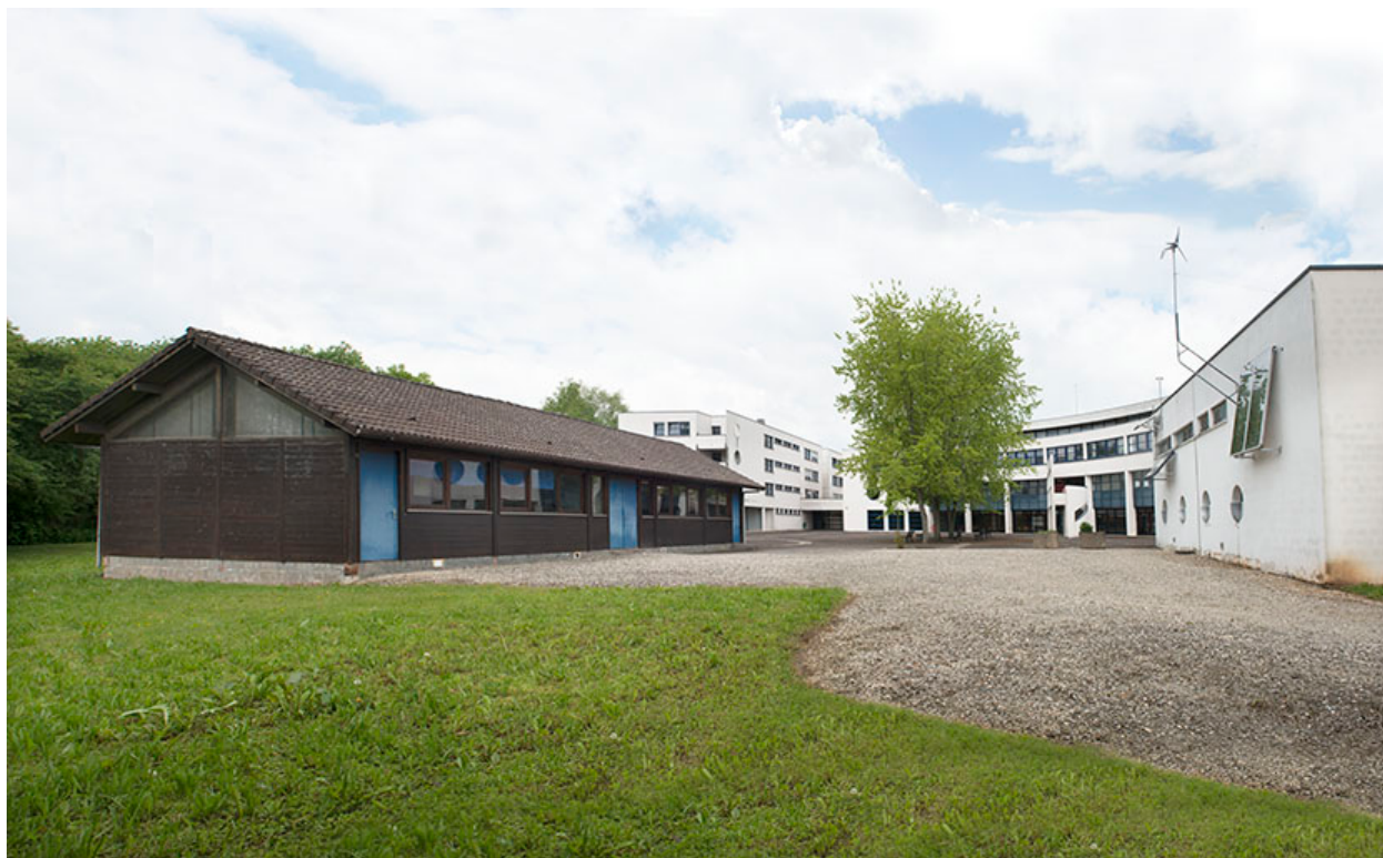
Angle sud-est du chalet et cour postérieure.
