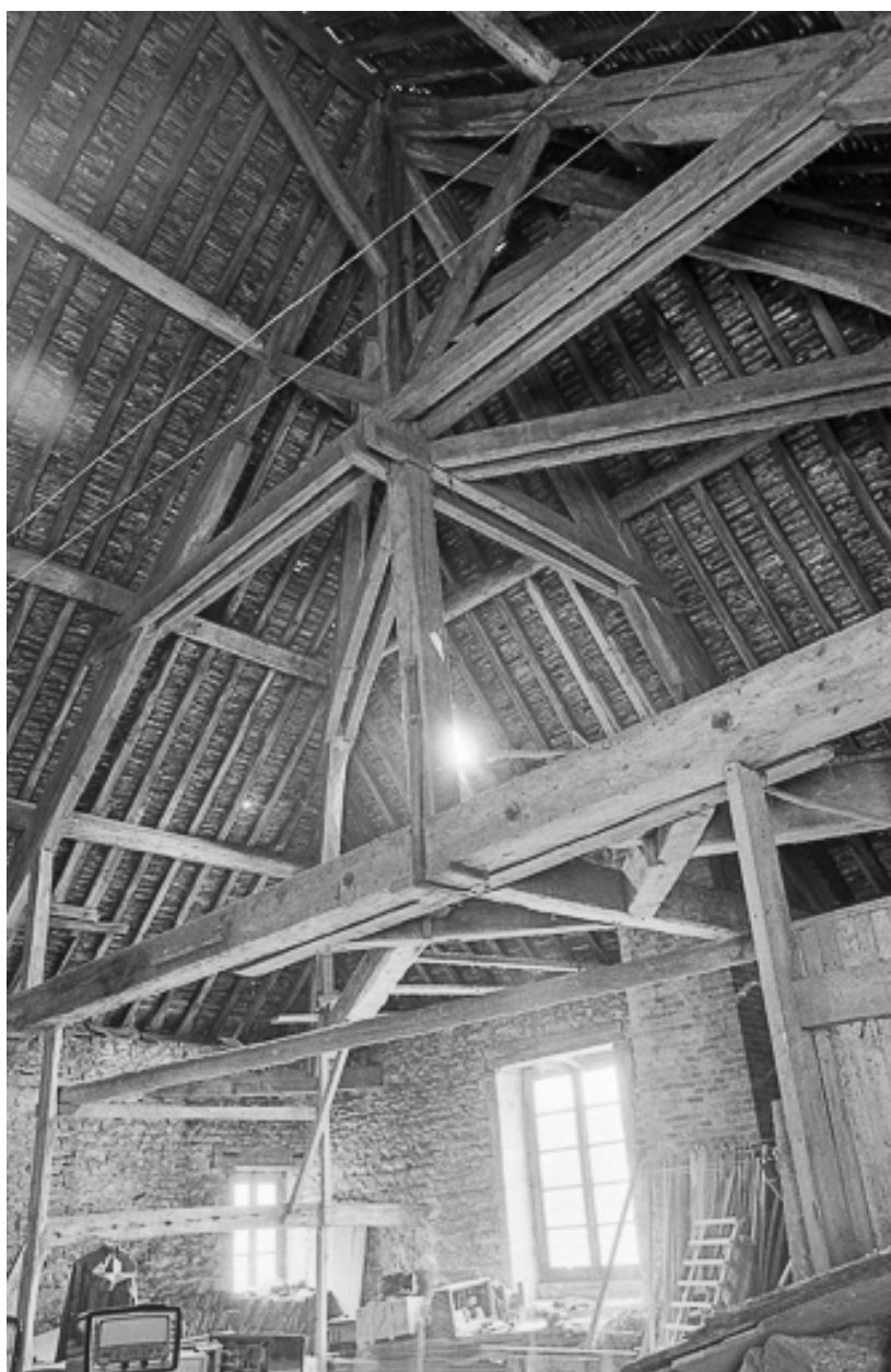
La charpente du haut fourneau en 1979.
