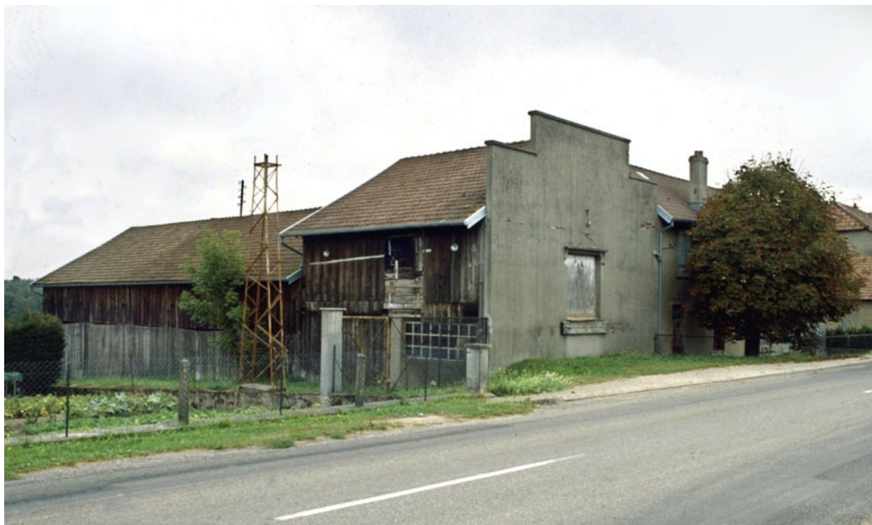
Magasin et entrepôt industriel.
