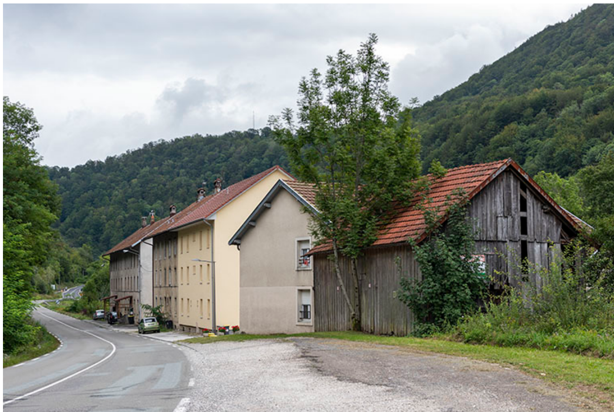
Vue d'ensemble, depuis la route à l'ouest.
