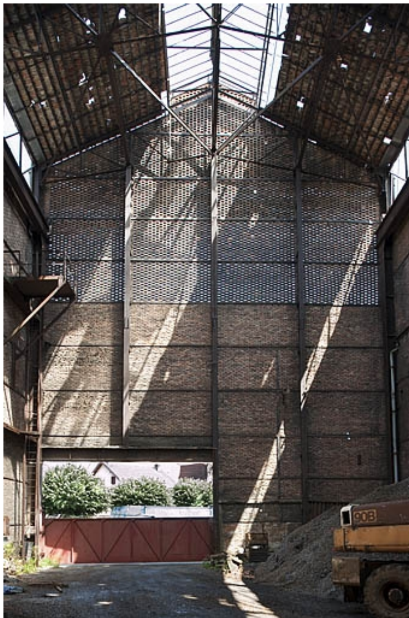
Bâtiment du gazogène. Vue intérieure depuis l'ouest.
