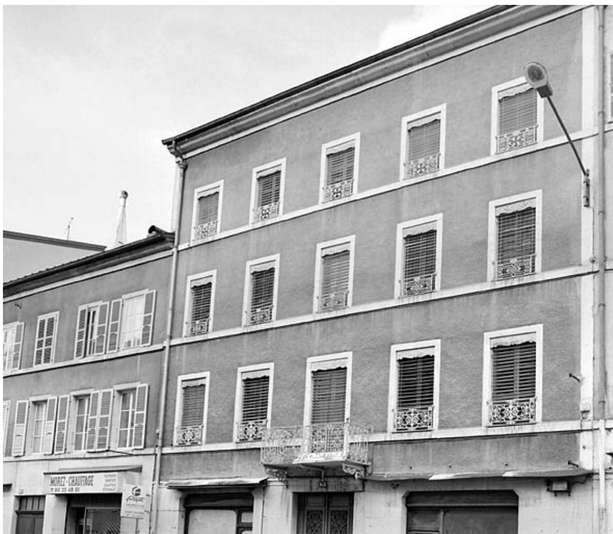
Elévation antérieure : les baies des étages.
