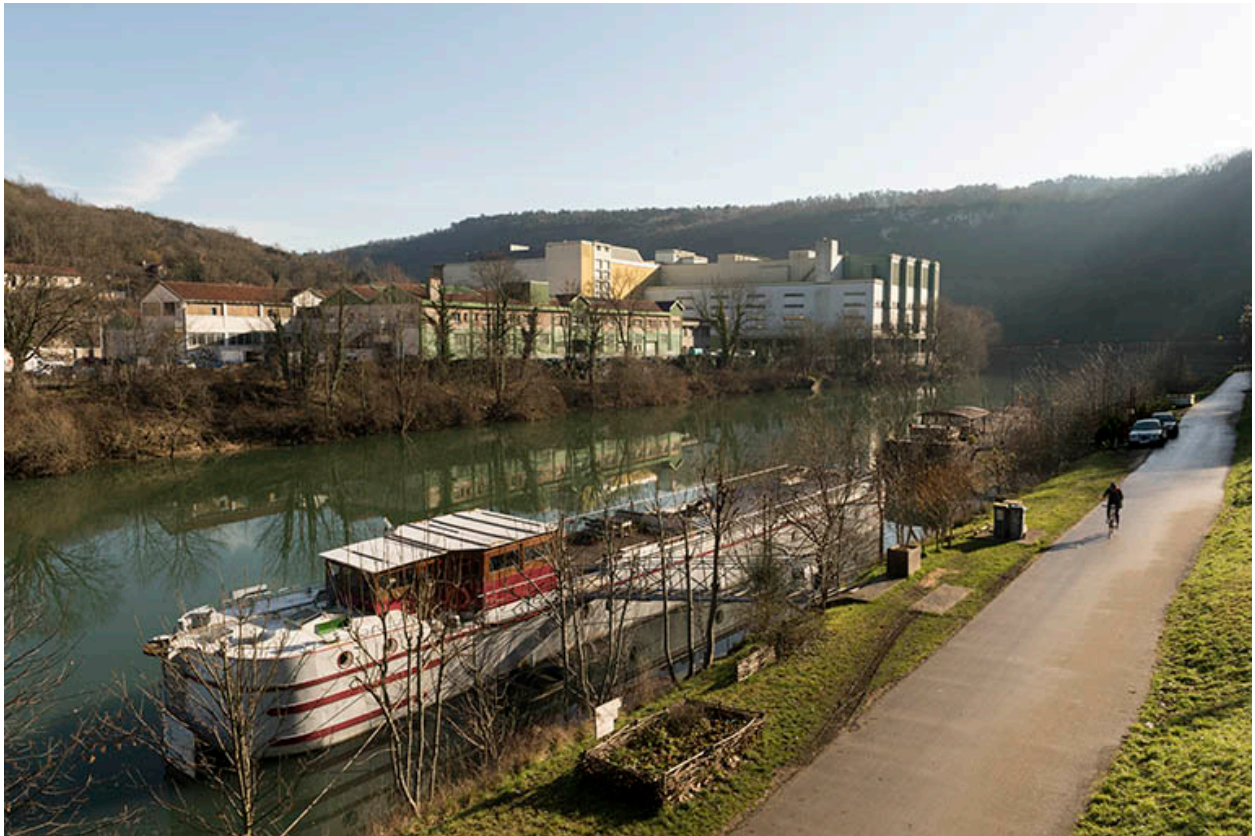
Etat en 2016. Usine B : vue d'ensemble depuis la rive gauche du Doubs, à l'ouest.
