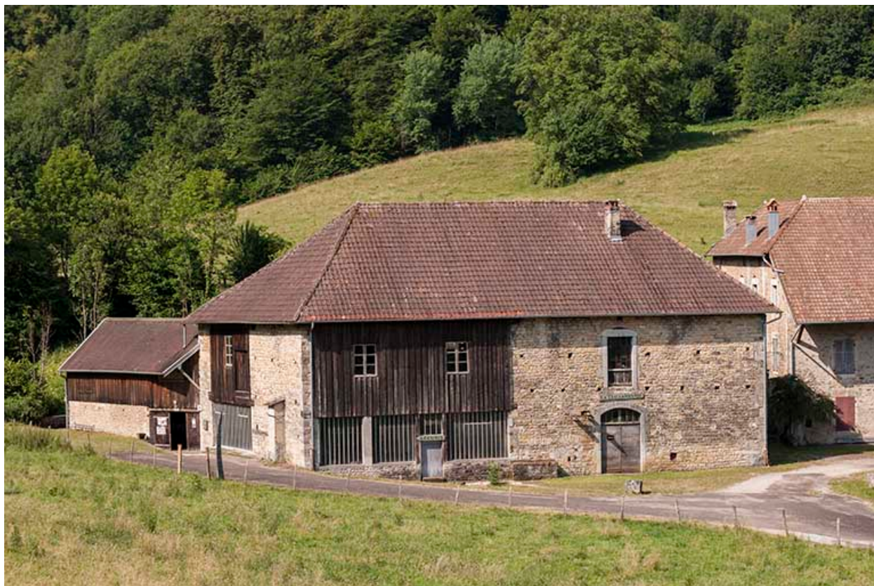
Façade nord de l'atelier de fabrication.
