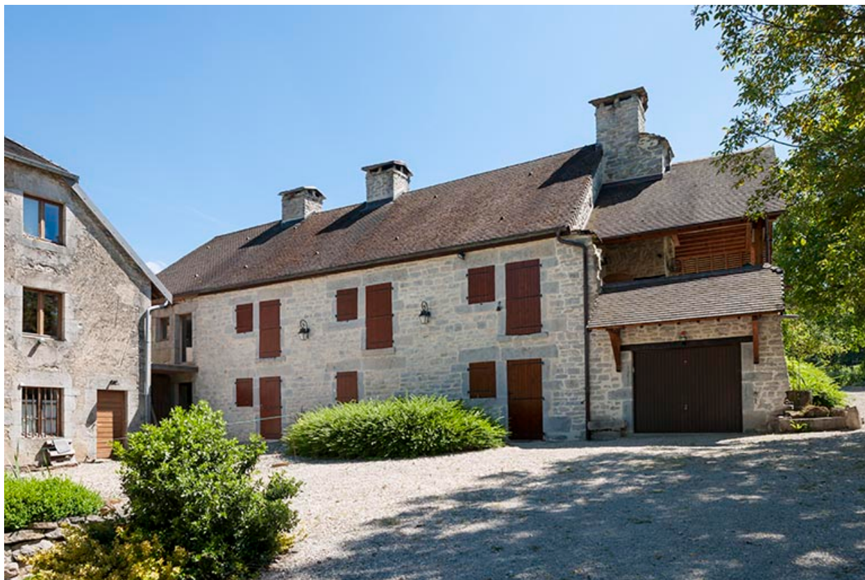
Logement d'ouvriers. Vue de trois quarts.
