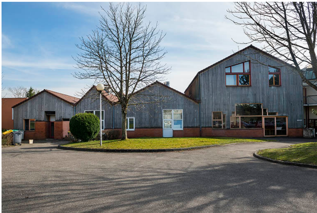
Pignons nord de la restauration.
