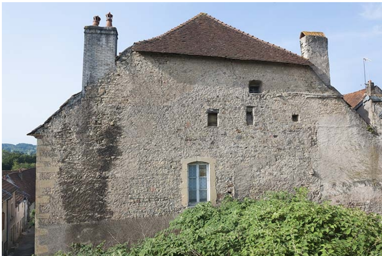
Façade latérale droite.
