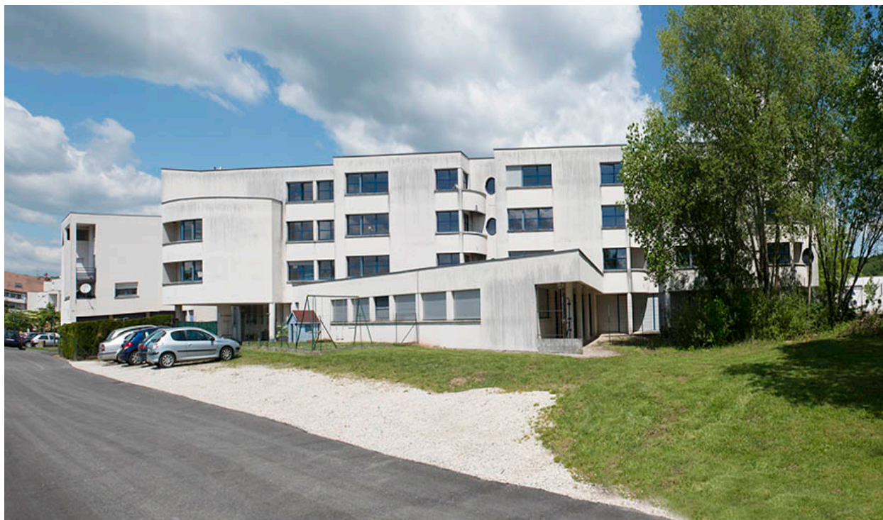
Façades ouest de l'internat.
