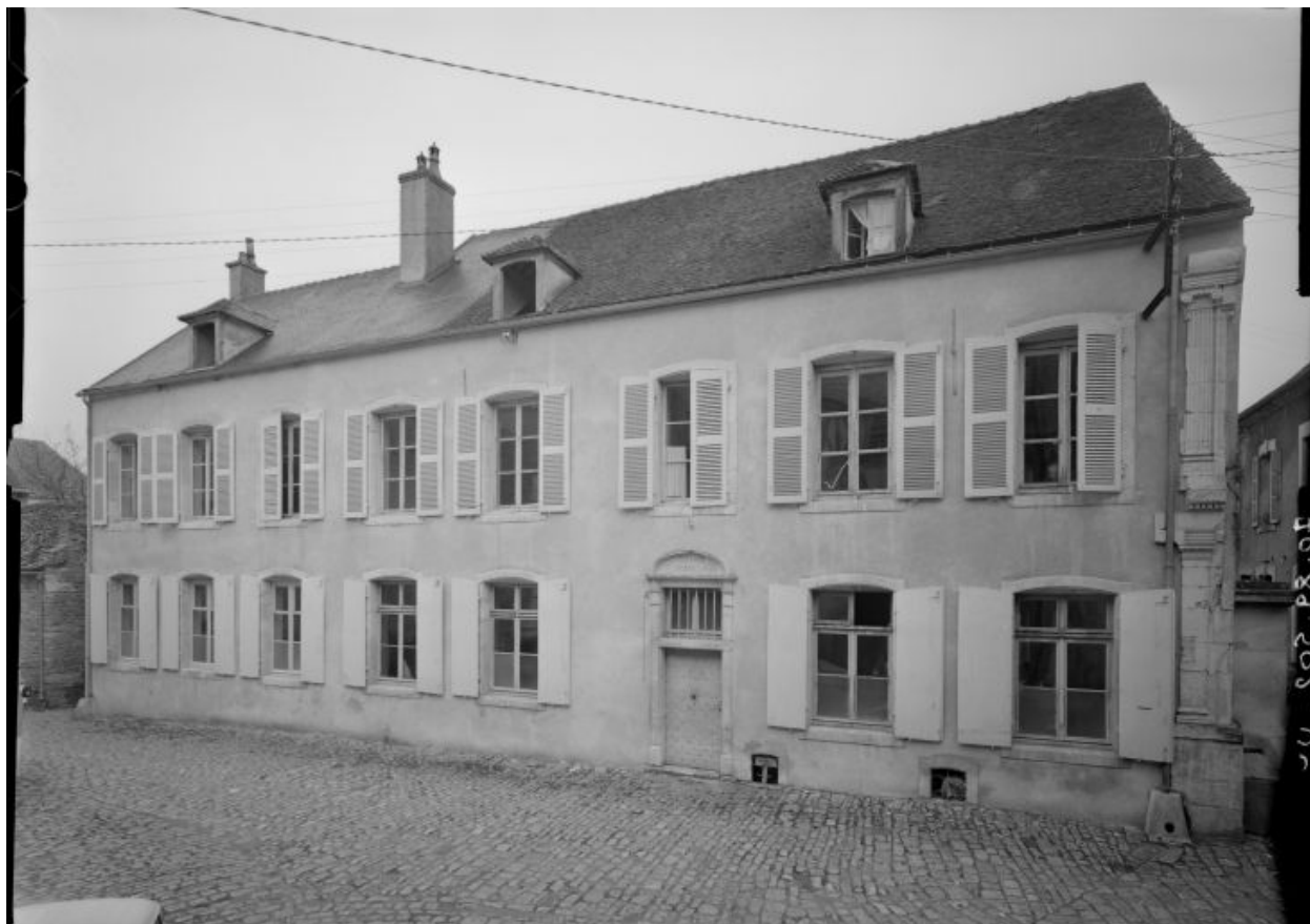
Façade sur la Petite Rue.
