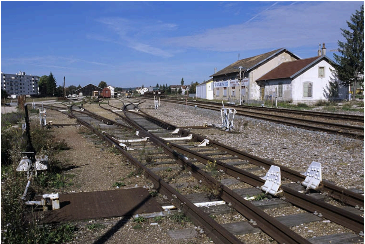
Aiguillages et faisceaux de voies côté La Cluse, depuis le sud-est.
