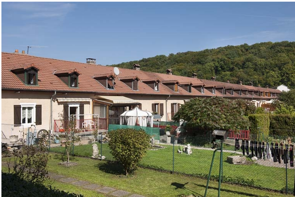
Caserne G. Façade postérieure depuis le sud-ouest.
