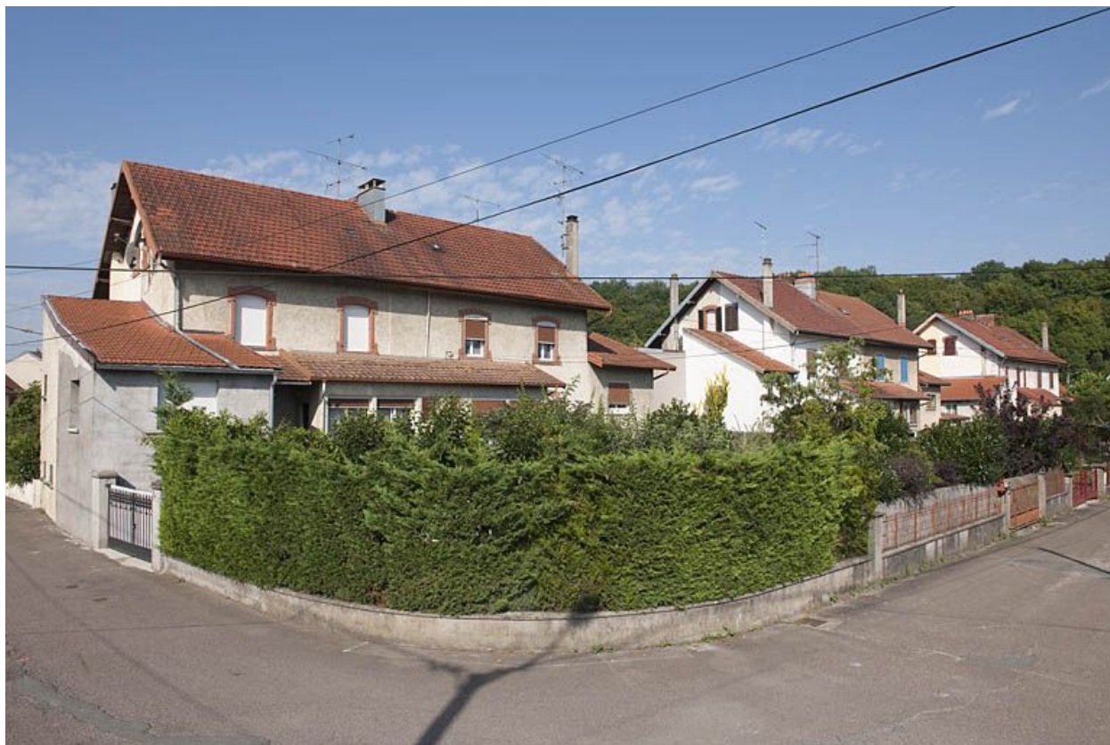
Habitations à 4 logements vues depuis l'est.
