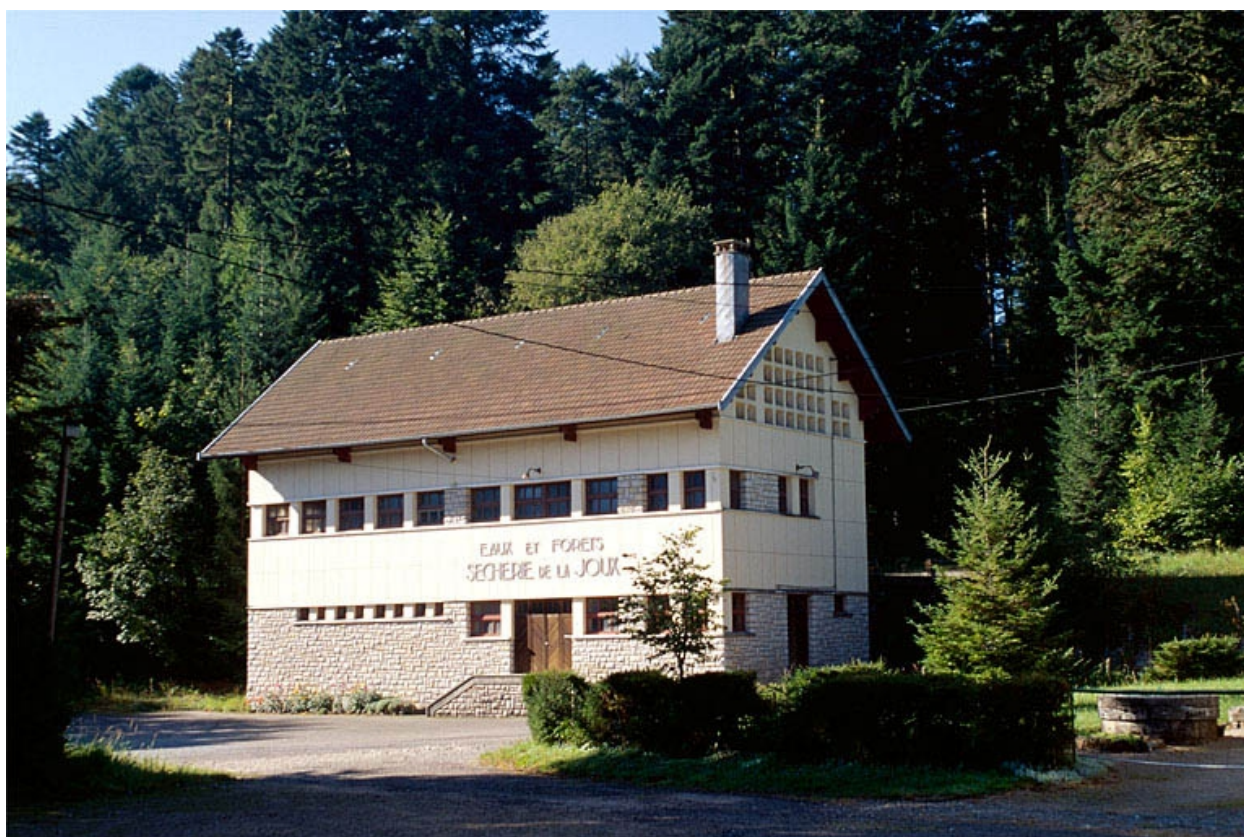
Vue d'ensemble de la sécherie résineuse.
