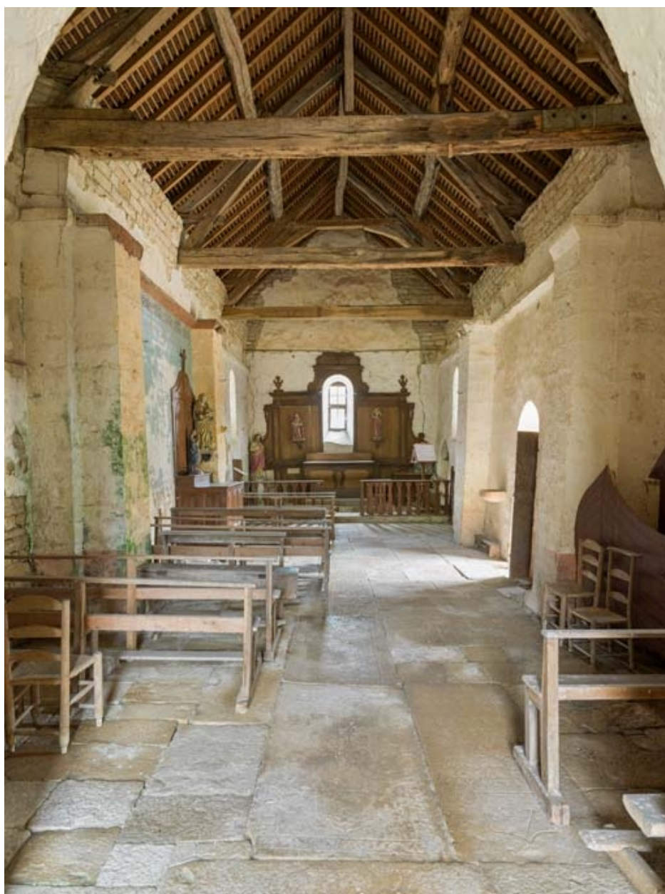
La nef, depuis l'entrée.
