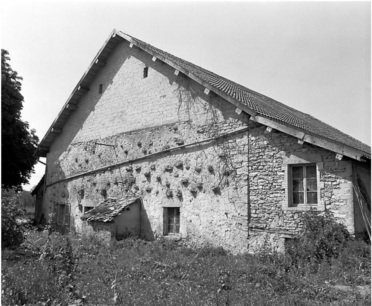
Ferme située rue du Chalet.
