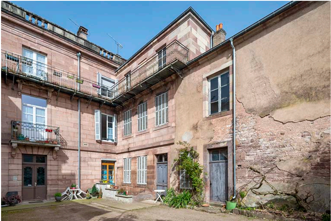
Façade sur la cour.
