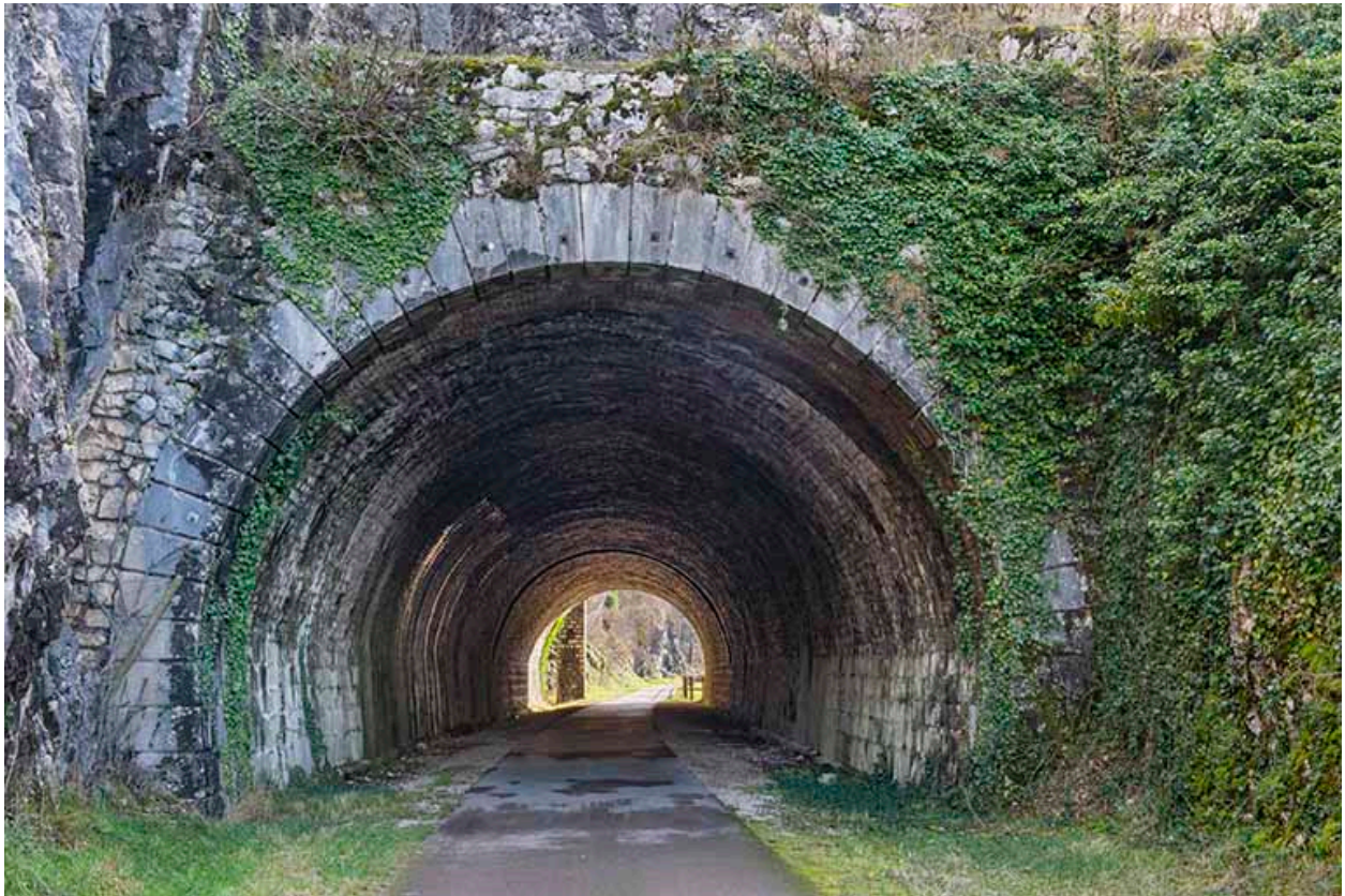
Entrée ouest du tunnel.
