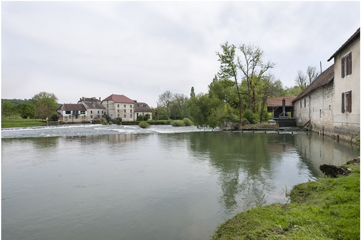
Vue d'ensemble depuis la rive droite.
