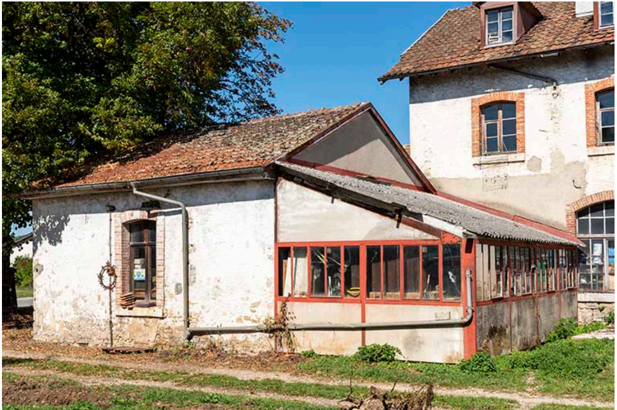
Forge et dépôt : façades postérieure et latérale droite.
