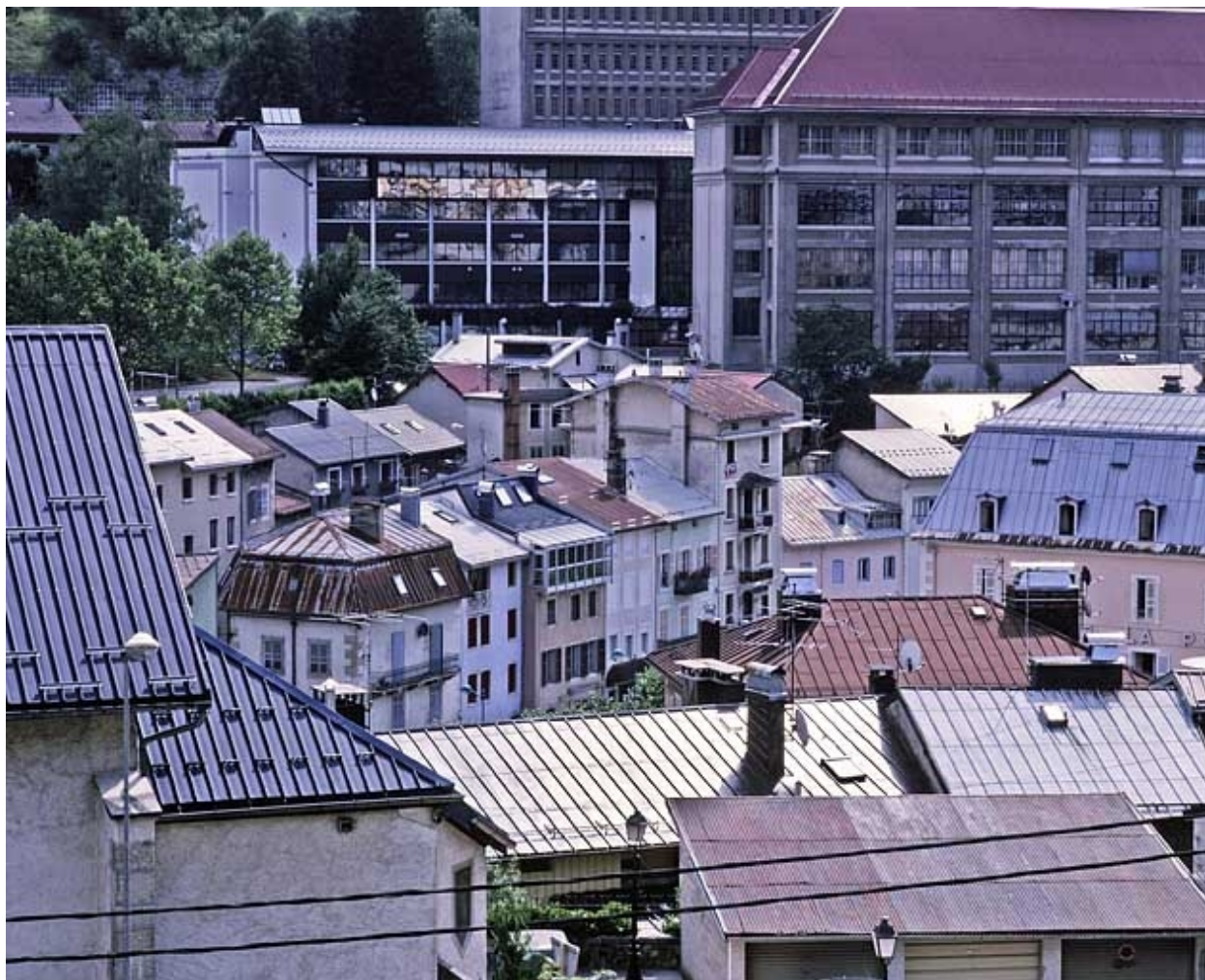
Toiture des bâtiments du quai Aimé Lamy.
