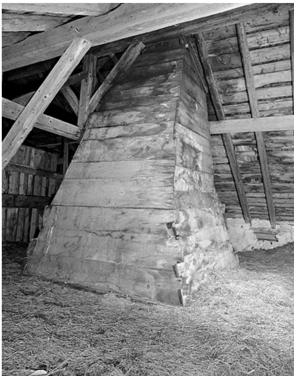
La cheminée en bois dans les combles.
