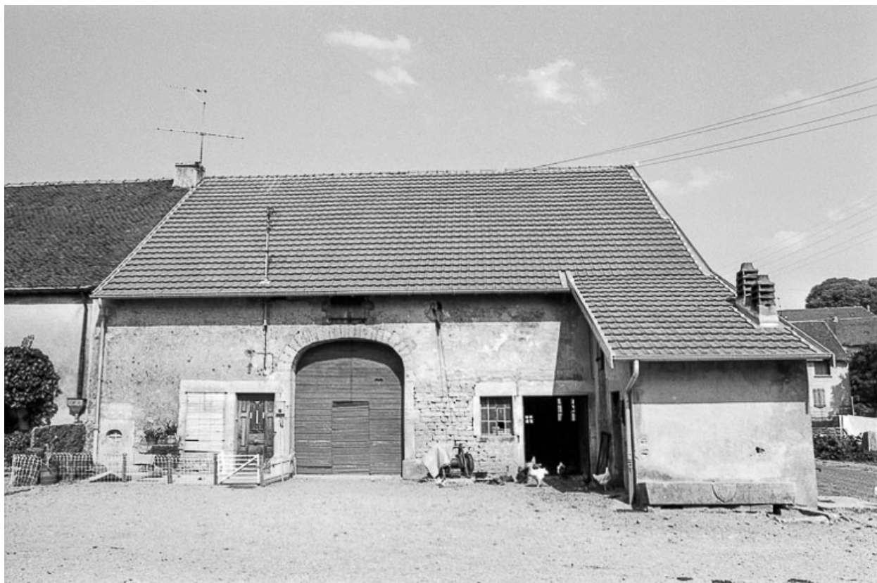
Ferme cadastrée D2 214 : façade antérieure.
