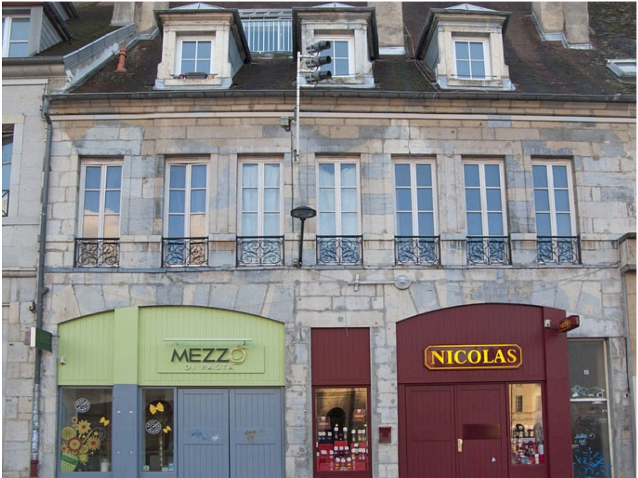
Vue d'ensemble rapprochée de la façade antérieure.
