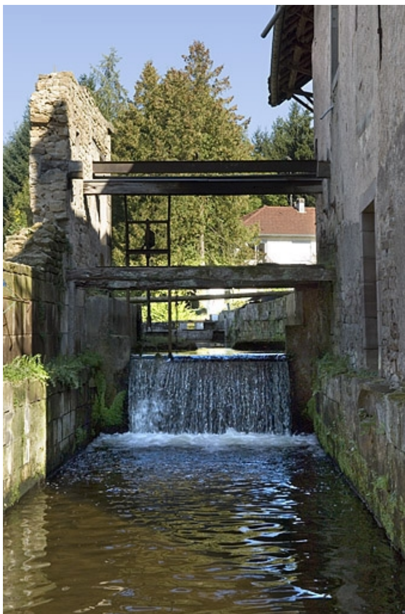
Bief de dérivation depuis l'aval.
