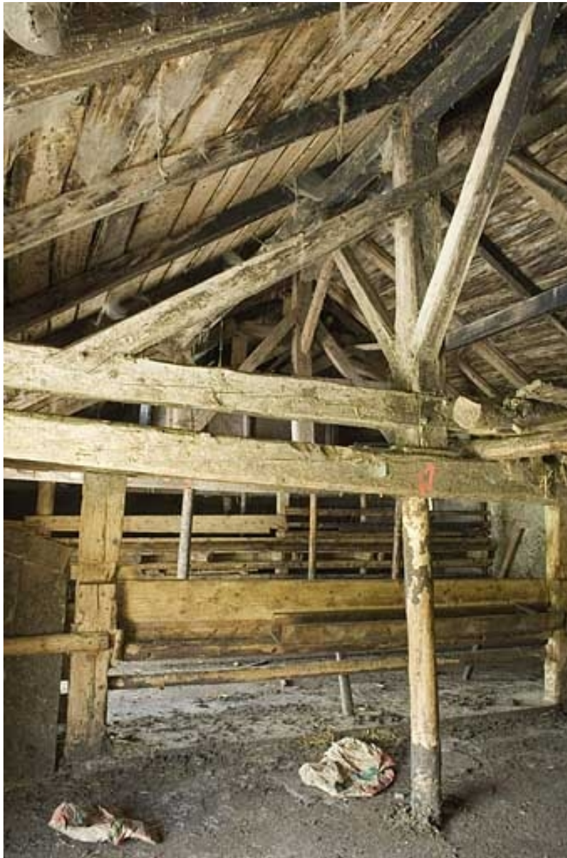
Détail de la charpente.
