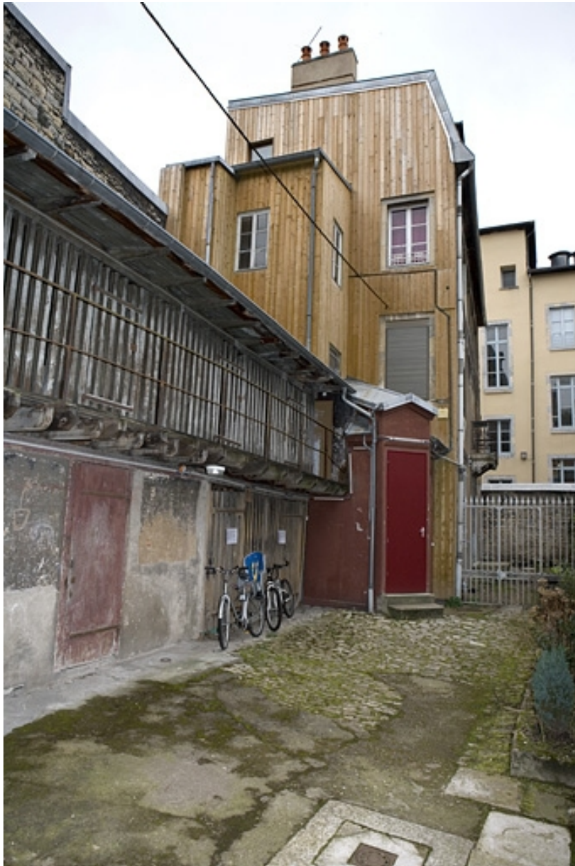
Vue d'ensemble des bûchers et du second logis secondaire situés dans la deuxième cour.
