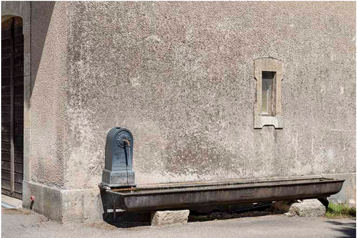
Borne-fontaine et auge d'abreuvoir en fonte situées contre la façade sud de la remise de matériel d'incendie.
