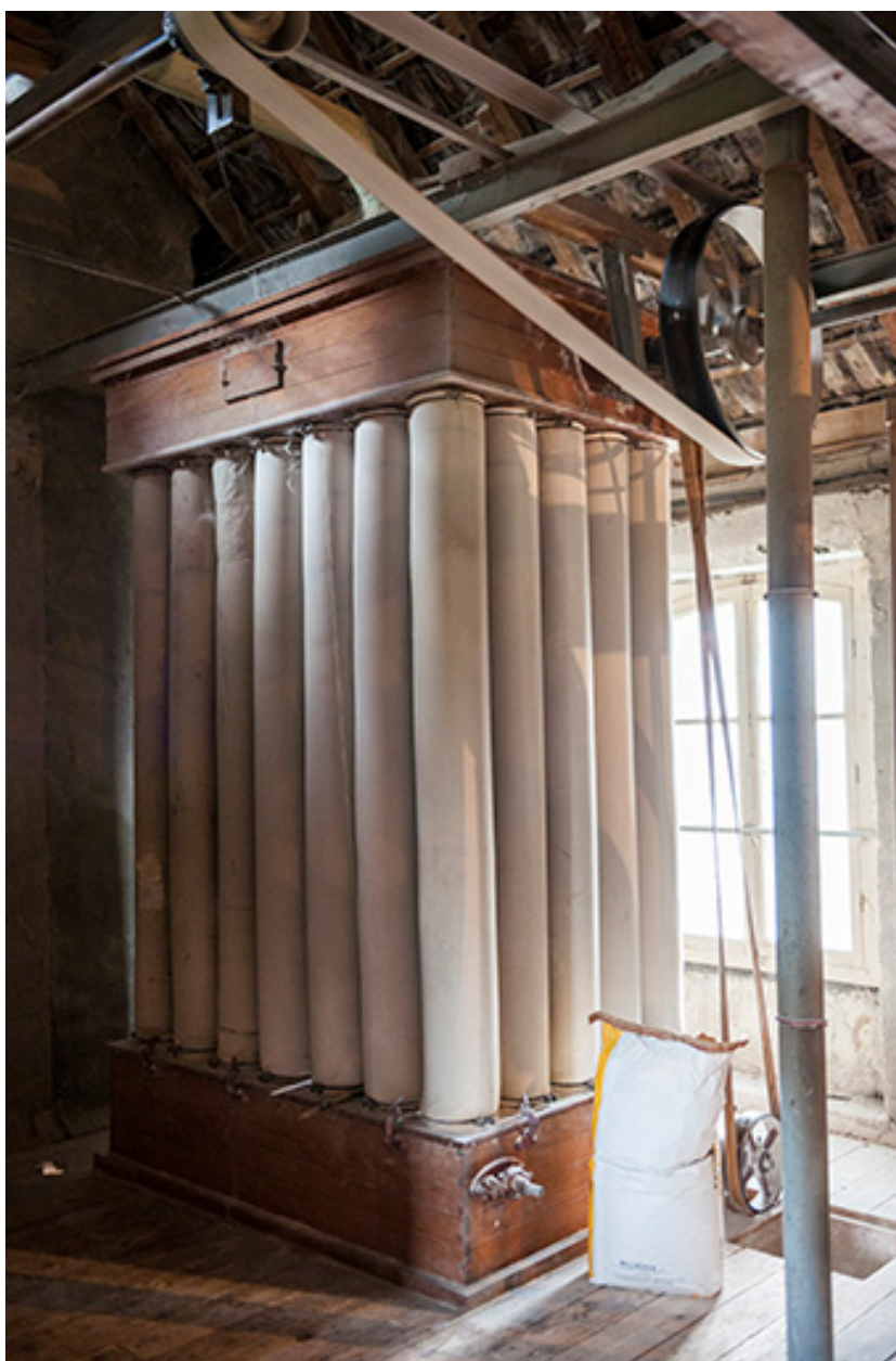
Troisième étage. Filtre à air.
